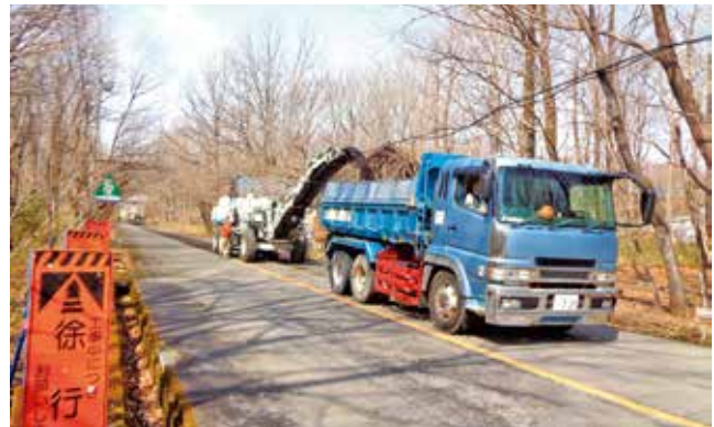
<作業風景 : 令和7年3月>
