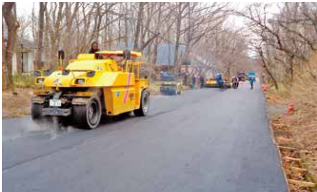
<作業風景 : 令和7年3月>
