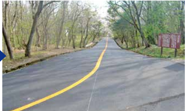
<補修工事後 : 令和7年4月22日撮影>
