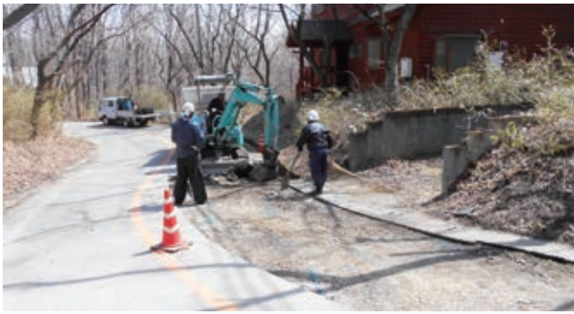
今春に行われた道路補修工事に引き続き、道路補修工事が8月上旬に行われます。(写真は春の工事風景)
