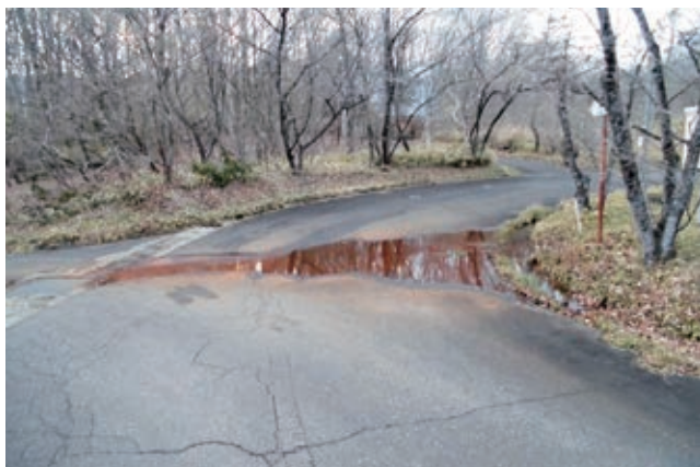
＜施工前：平成29年12月6日＞
