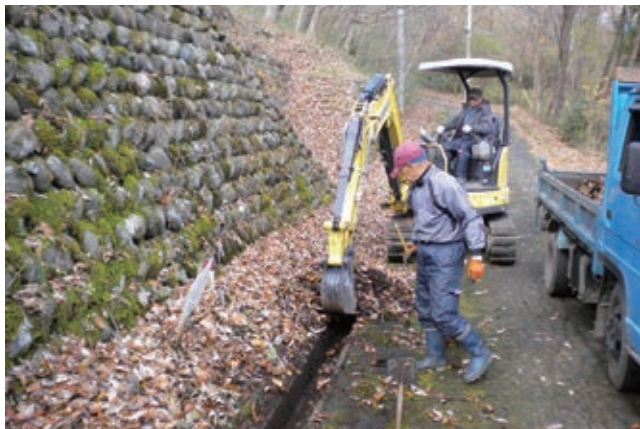
＜作業風景：平成29年11月＞
