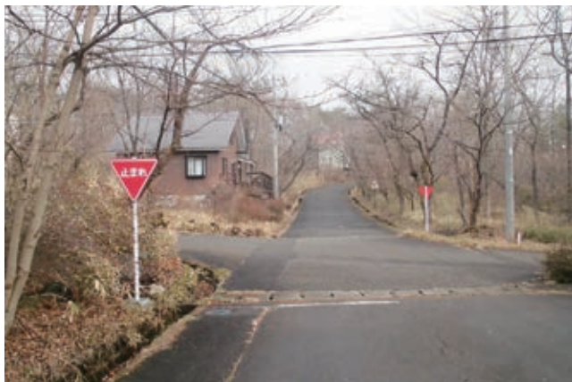
＜一時停止標識5基設置：平成29年12月＞
