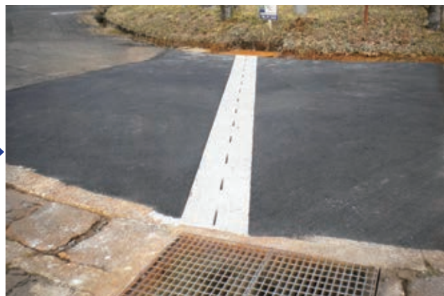
＜施工後：平成29年12月21日＞
