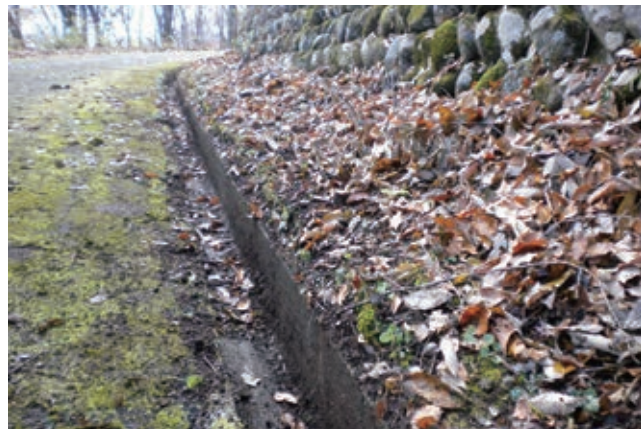
＜作業後の側溝：平成29年11月＞
